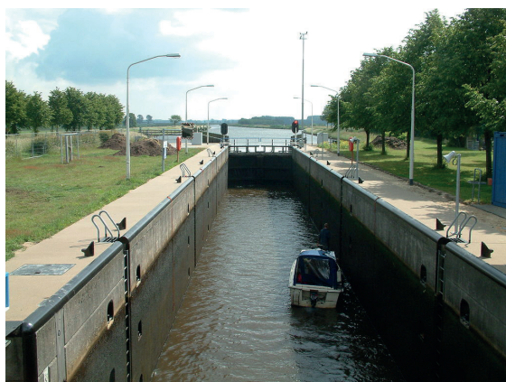
Ossesluis in de Hoogeveensevaart
